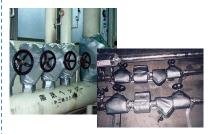
蒸気配管に限らず、ヘッ ダーやバルブ等の断熱 材が巻きにくい箇所にも 専用の断熱材を巻くこと で熱エネルギーの放熱を 防ぎ、保温する。
