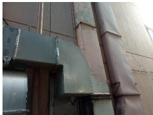
工場内の熱の換気や排気が うまくいっていない・・・
