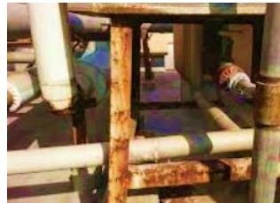
強酸霧困気で鉄骨や 架台・タンクが錆びる・・・
