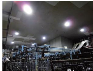
オイルミストで照明が すぐに劣化する・・・
