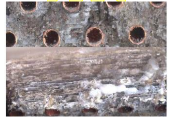
オイルミストで空調機の 熱交換器が劣化する・・・
