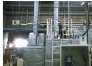
工場内の熱源で 作業環境が暑い・・・
